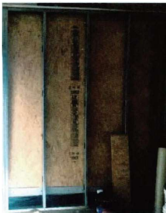
Figura A.2—Fijación de las placas LP OSB
