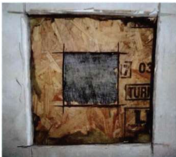
Figura 4—Ventana de inspección sin señales de humedad, goteo o exudaciones en la barrera impermeable.
