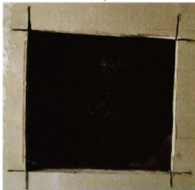
Figura 6 – Ventana de inspección sin signos de humedad, goteando o supurando en la barrera impermeable.
